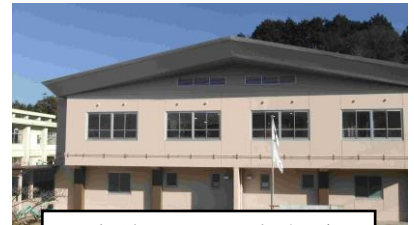
体育館、もうすぐ完成です
